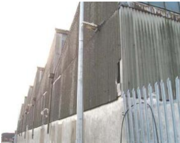
Figura 11 – Revestimento em chapa ondulada de fibrocimento na fachada de um edifício
