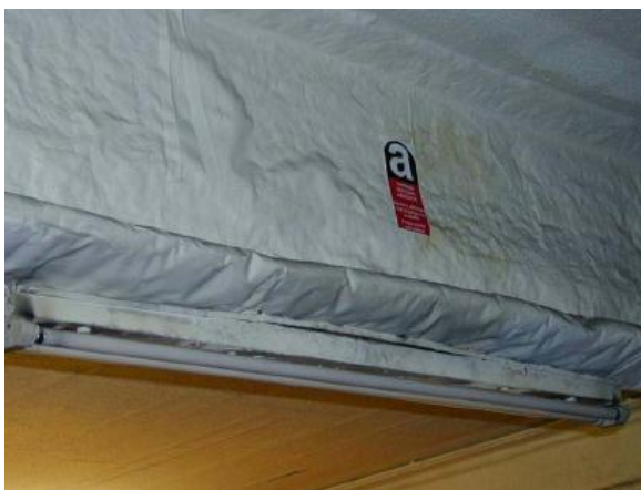
Figura 12 – Estrutura de aço com isolamento de amianto (protecção ignífuga)
