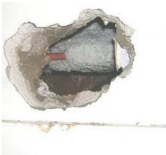
Figura 4 – Isolamento de tubagem embutida na parede
