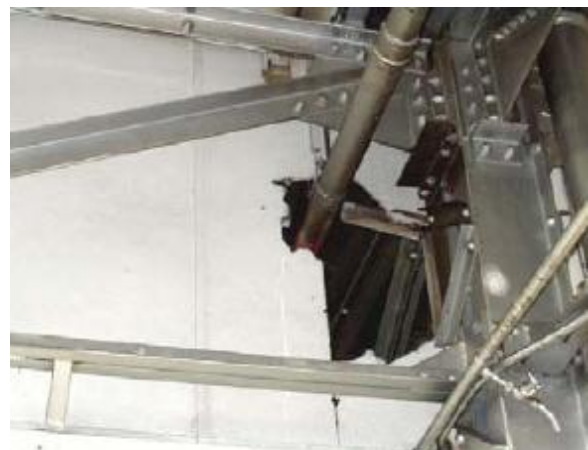
Figura 3 – Divisória de painel de isolamento
